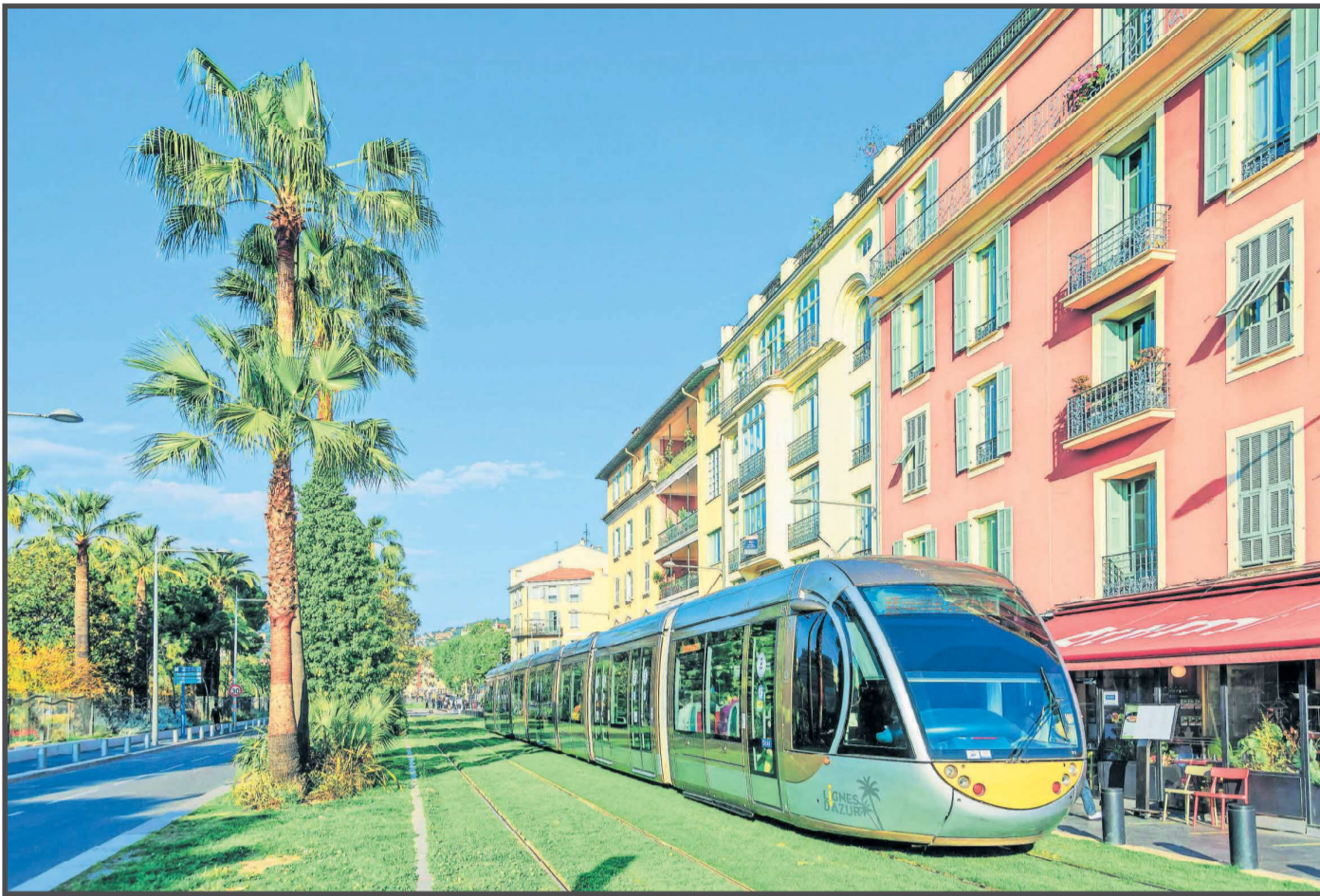
Fast lautlos und ohne störende Oberleitung gleiten die Straßenbahnen auf begrünten Gleisen durch das Zentrum von Nizza. [Foto: Viennaslide]
